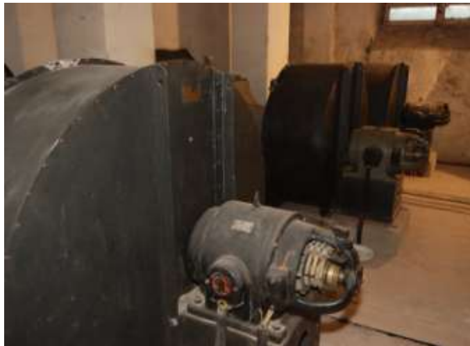
Silniki marki Skoda i wentylatory z wytwórni Waberskiego – serce urządzenia. Fot. Agnieszka Markiton.
